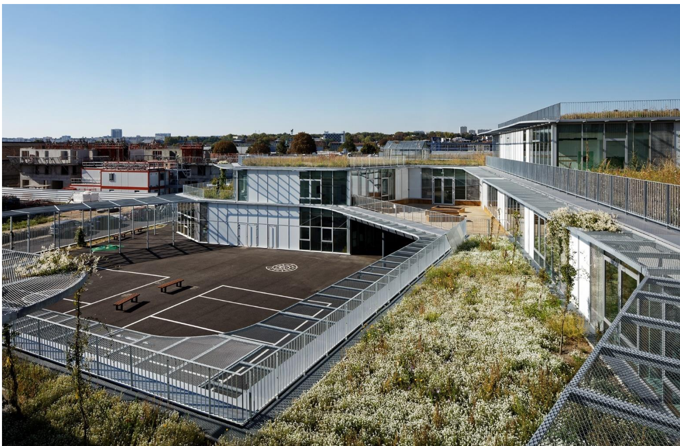
Obr. 1.1 Aplikácia zelene na budove školy vo Francúzsku
