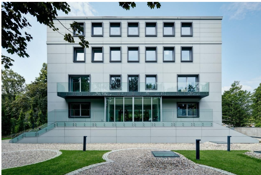
Obr. 1.19 Úprava okolia budovy
