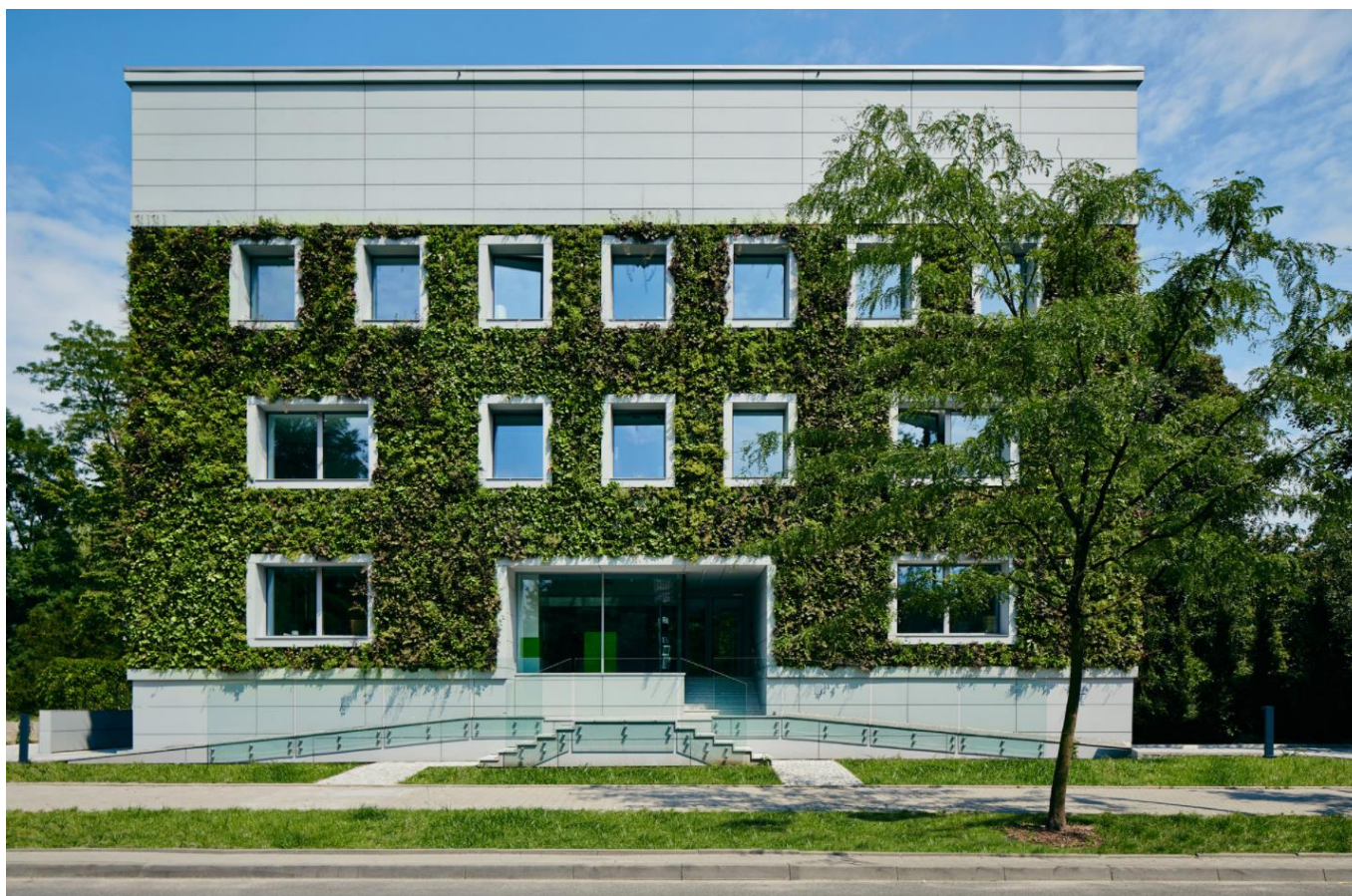
Obr. 1.15 Súčasná fasáda budovy – po renovácii
