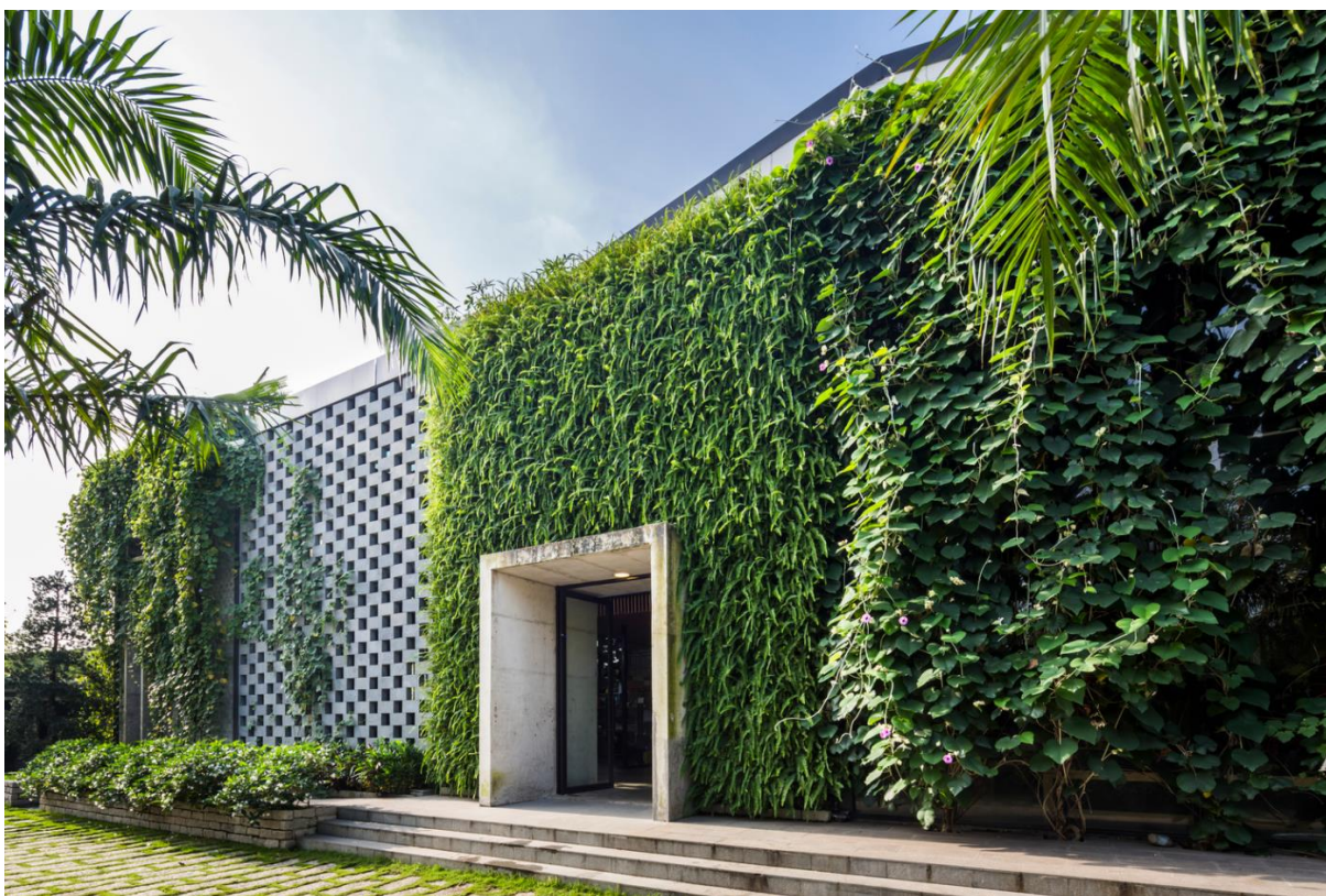
Obr. 1.21 Vstup do budovy
