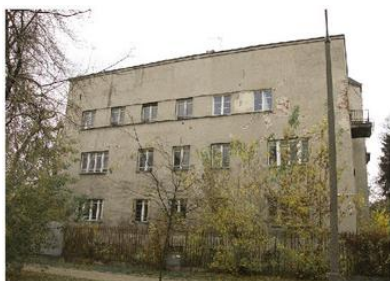
Obr. 1.14 Pôvodná fasáda budovy – pred renováciou
