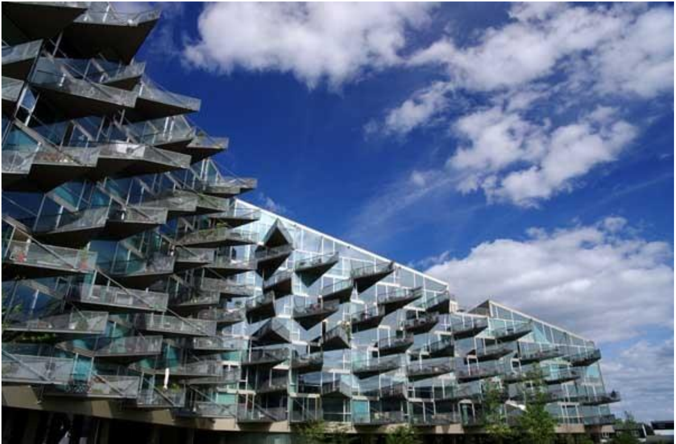
Obr. 1.60 Trojuholníkové balkóny bloku „V“
