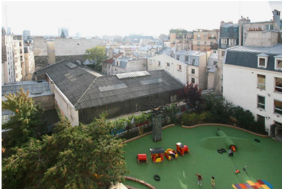
Obr. 1.25 Pôvodný nízkopodlažný sklad
