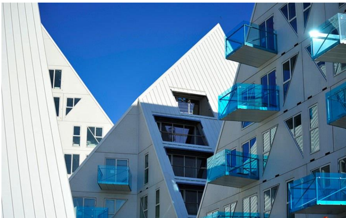
Obr. 1.49 Pohľad na strechu a fasádu budovy
