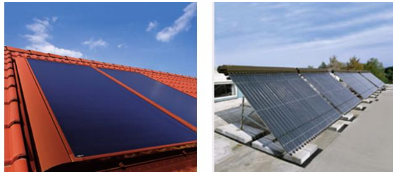
Obr. 6.33 Porovnanie aplikácie kolektorov: a) na konštrukcii strechy, b) súčasť strešnej krytiny
