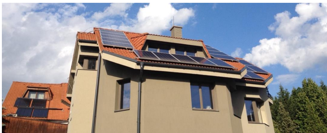
Obr. 6.56 Inštalácia fotovoltaického systému – variant A
