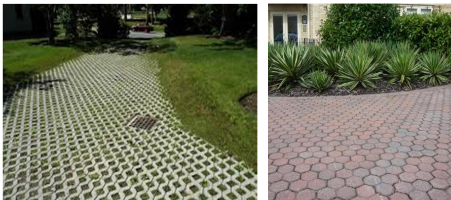
Obr. 5.34 Pripustná dlažba Stamford, UK
