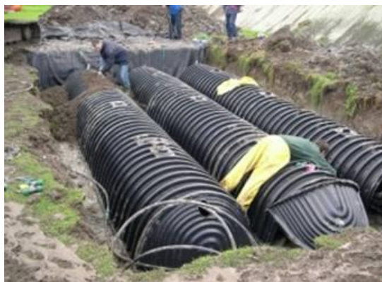
Obr. 5.43 Tunelový vsakovací systém
