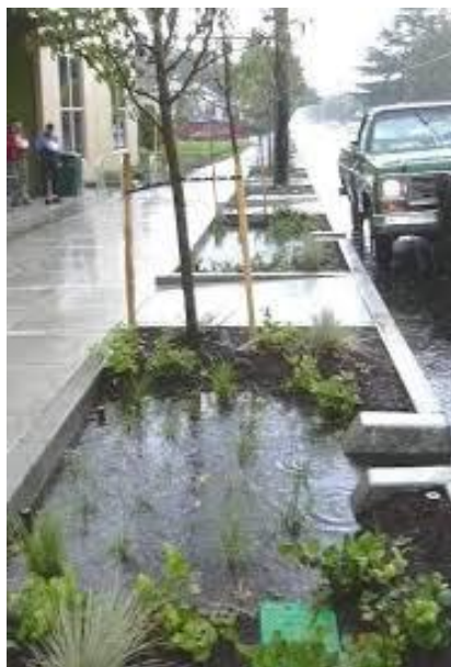
Obr. 3 Bioretencia dažďovej vody vo verejnom priestore (vľavo), Príklad zosúladenia biokoridoru v urbanizovanom prostredí (vpravo)
