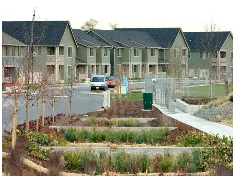
Obr. 3 Bioretencia dažďovej vody vo verejnom priestore (vľavo), Príklad zosúladenia biokoridoru v urbanizovanom prostredí (vpravo)
