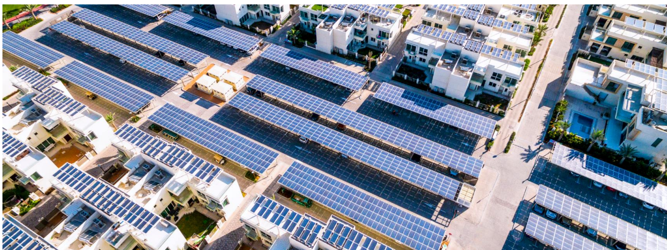
Obr. 7 Parkovisko s prestrešením pomocou fotovoltaických panelov
