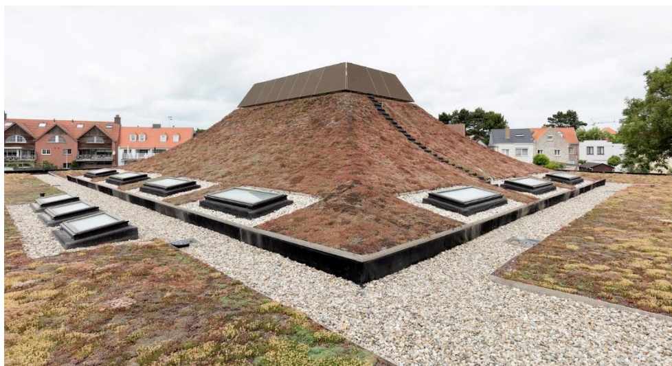
Obr. 8 Reálny pohľad na konštrukciu zakrivenej vegetačnej strechy s integrovanými strešnými svetlíkmi
