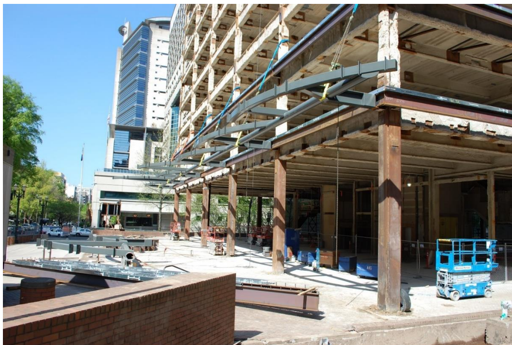
Obr. 6 Inštalácia nosných častí konštrukcie vonkajšieho tienenia na západnej fasáde budovy
