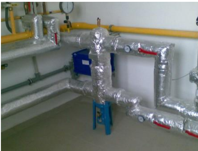
Obr. 2.8 Hydraulický vyrovnávač dynamických tlakov
