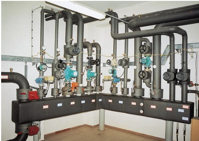
Obr. 2.7 Združený rozdeľovač / zberač
