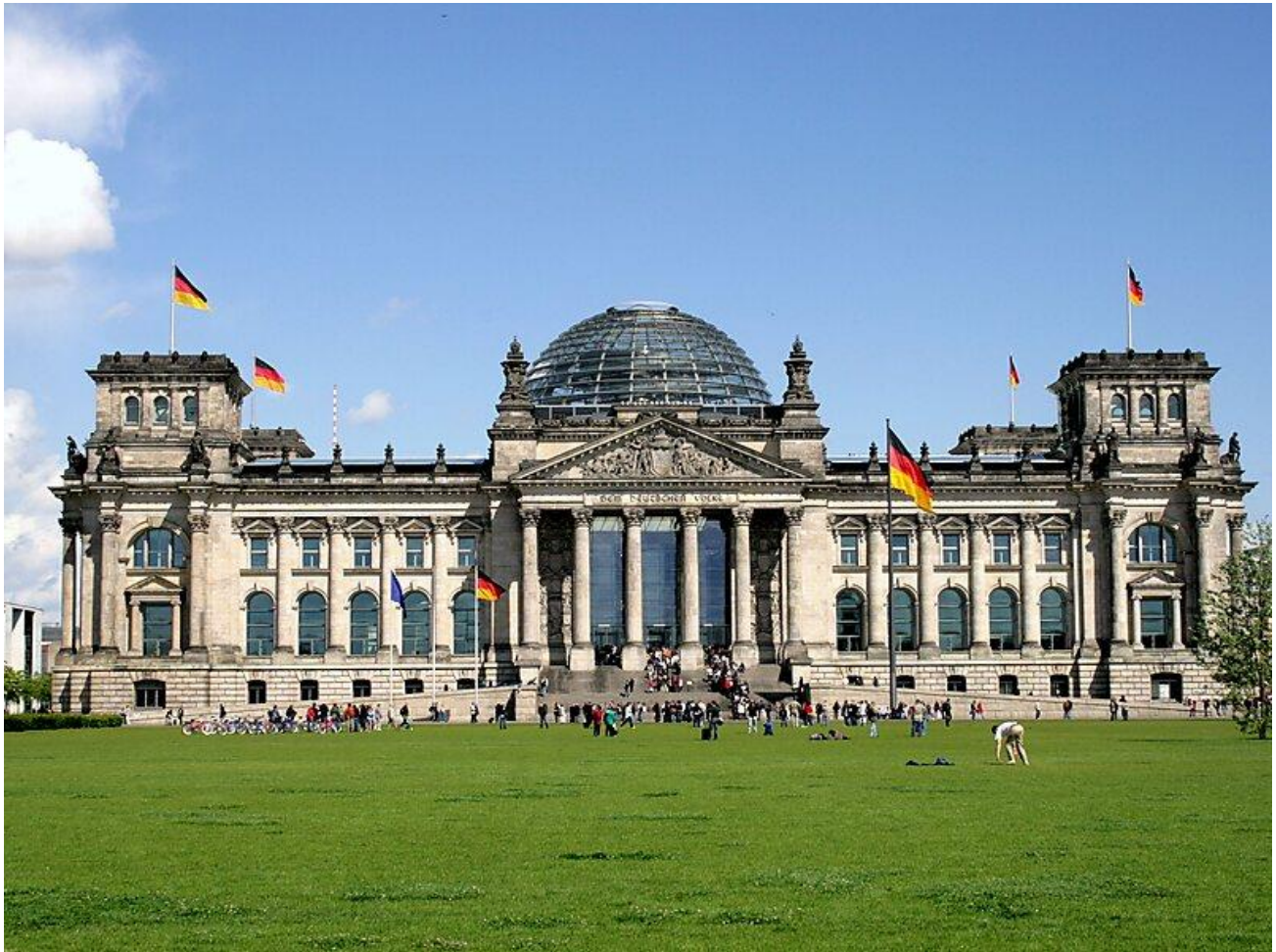
Obr. 7.16 Rekonštrukcia budovy Reichstagu, Berlín
