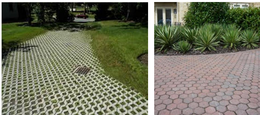
Obr. 5.34 Pripustná dlažba Stamford, UK
