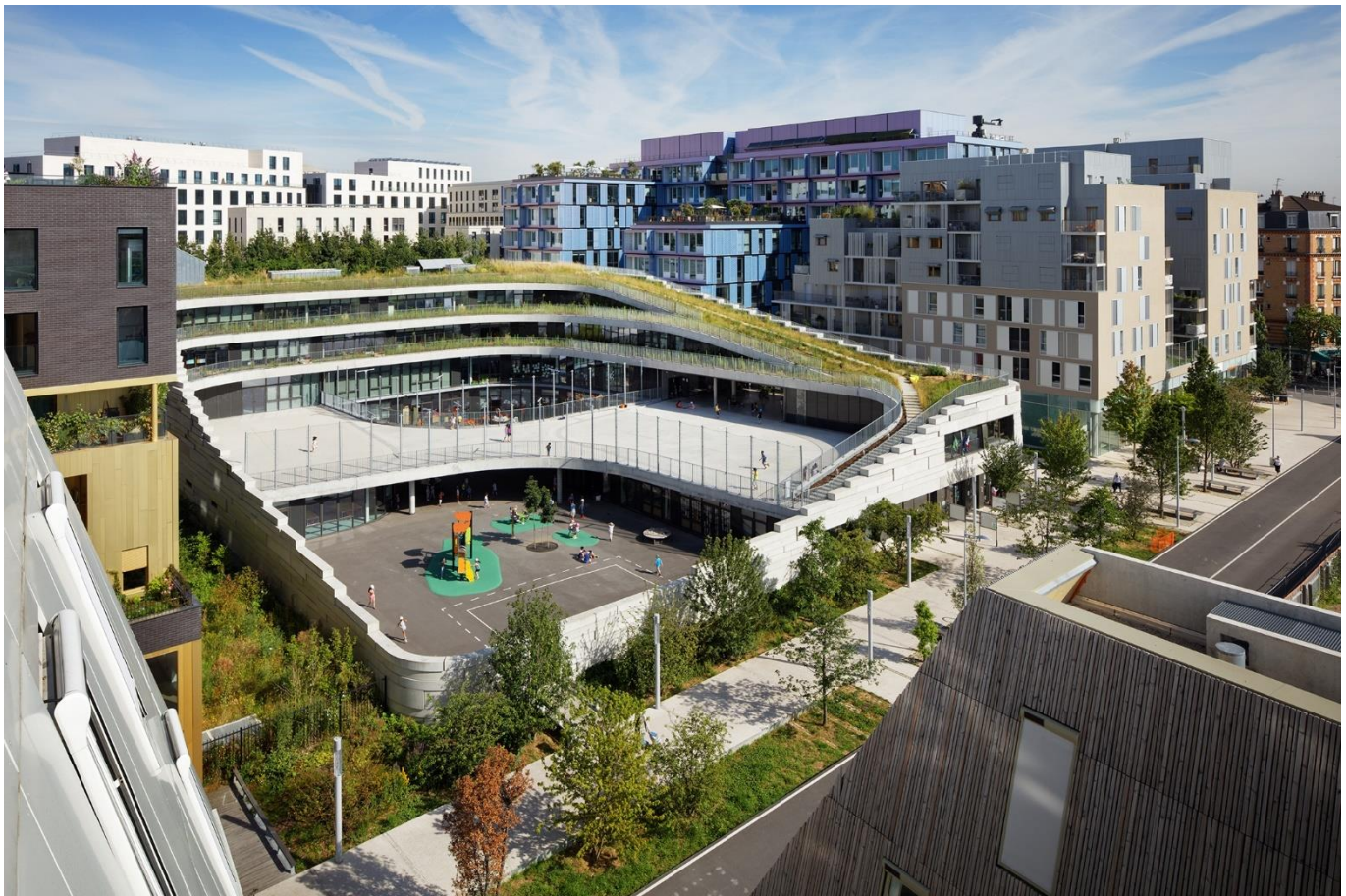
Obr. 1.12 Pohľad na budovu školy s prvkami zelenej architektúry
