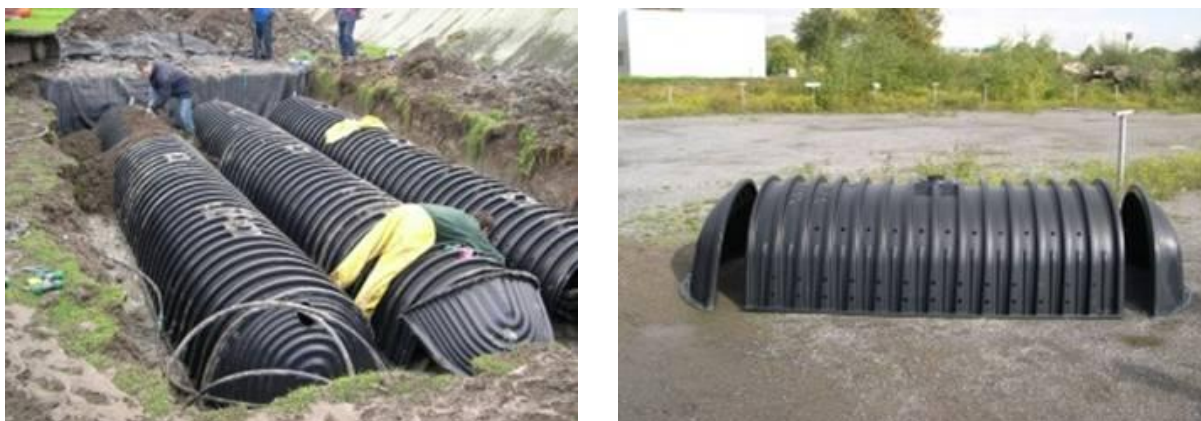
Obr. 5.28 Tunelový vsakovací systém
