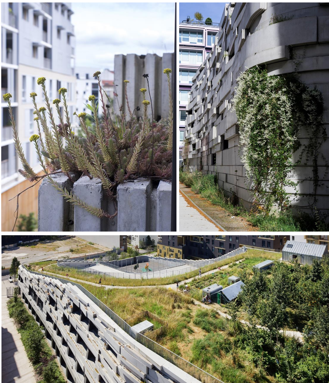
Obr. 1.13 Detailný pohľad na fasádu budovy, ktorá má podporiť vznik a rozvoj flóry a fauny
