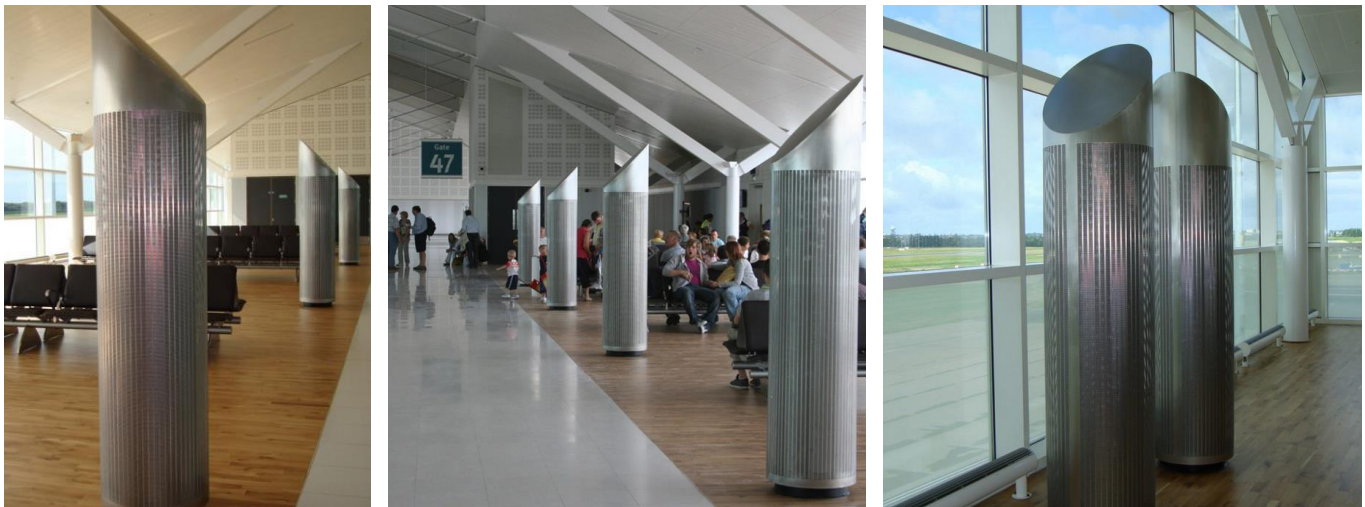
Obr. 2.40 Zaplavovacie distribučné elementy – fotky aplikácie v praxi
