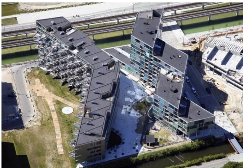
Obr. 1.65 Pohľad na budovy
