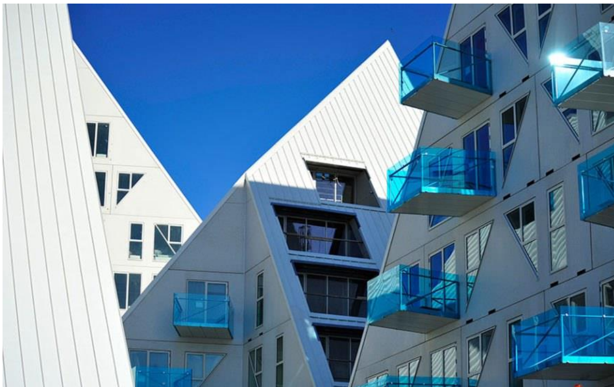
Obr. 1.49 Pohľad na strechu a fasádu budovy
