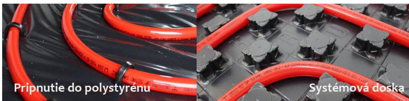
Obr. 2.2 Podlahový systém vykurovania
