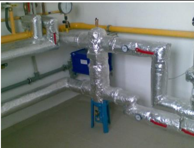
Obr. 2.8 Hydraulický vyrovnávač dynamických tlakov
