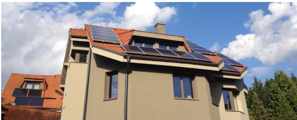
Obr. 6.56 Inštalácia fotovoltaického systému – variant A
