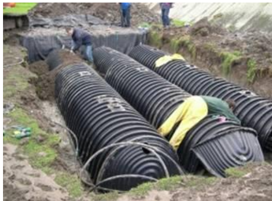
Obr. 5.43 Tunelový vsakovací systém
