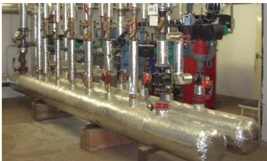
Obr. 2.6 Rúrový rozdeľovač a zberač
