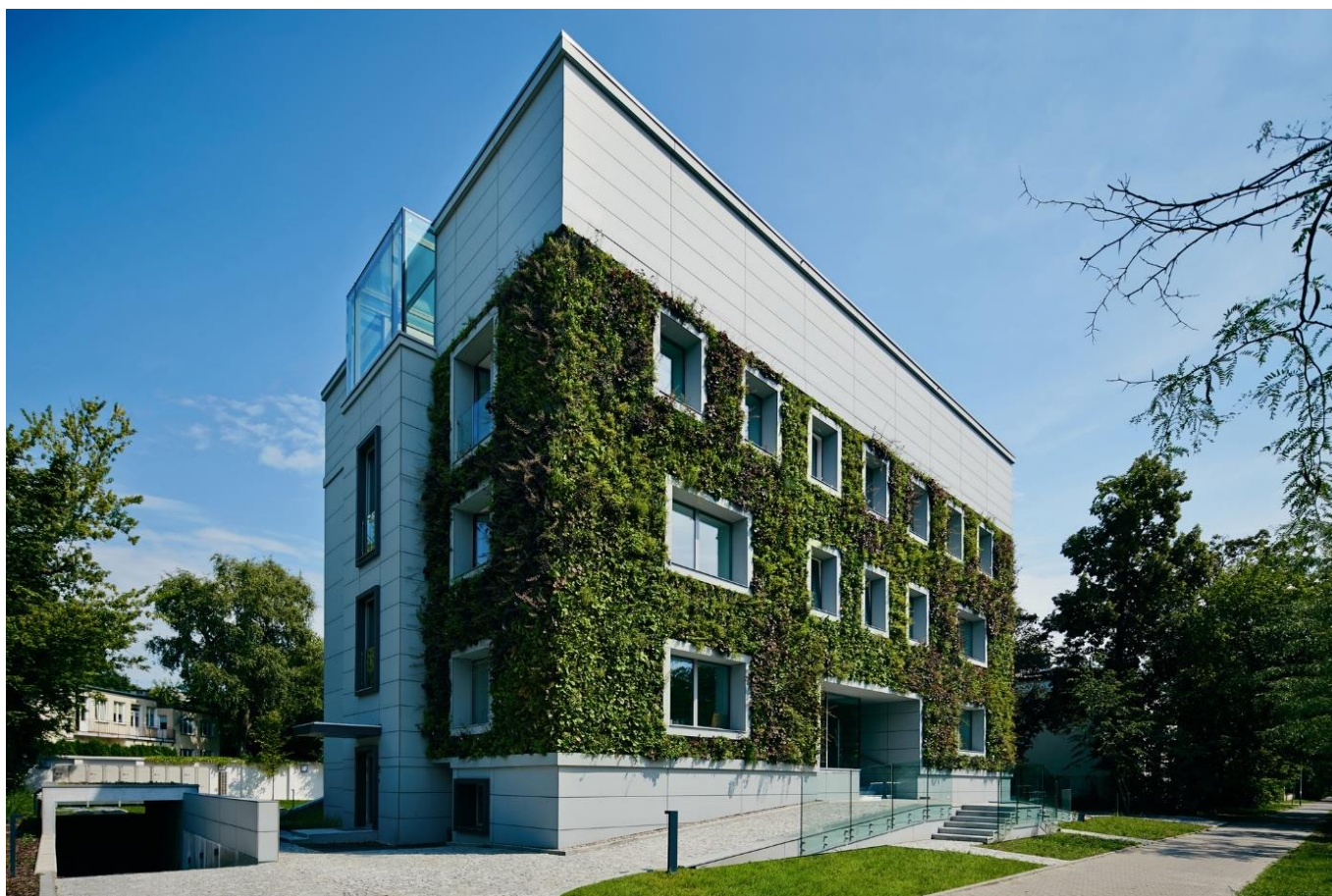
Obr. 1.13 Pohľad na zelenú fasádu renovovanej budovy
