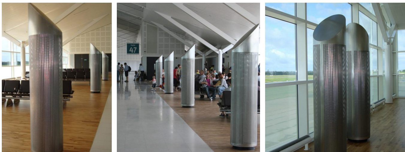
Obr. 2.46 Zaplavovacie distribučné elementy – fotky aplikácie v praxi
