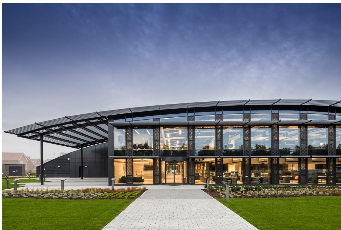
Obr. 1.5 Južná fasáda budovy CABI
