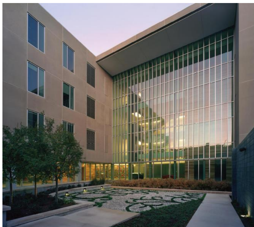
Obr. 21 Pohľad na fasádu budovy z vnútorného átria stavby
