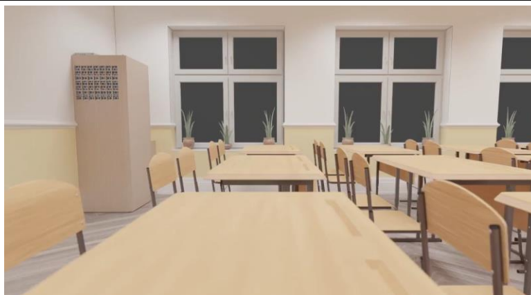
Vetracia jednotka Duplex Inter s rekuperáciou tepla v učebni (ATREA)
